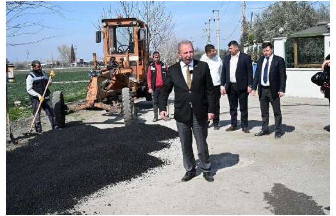
“Yol Yapım Çalışmaları”
